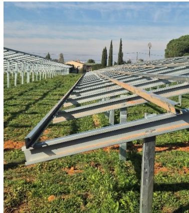
Figure 3 : Montage des structures – Octobre 2024
