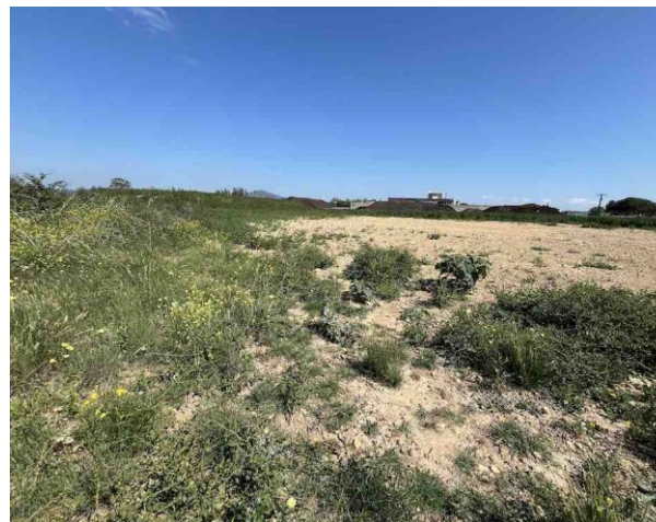
Pied de remblai, fraîchement régalez
